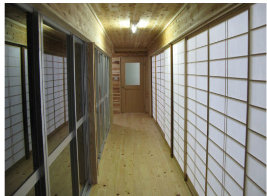
廊下(床材:ヒノキ、天井:スギ)
