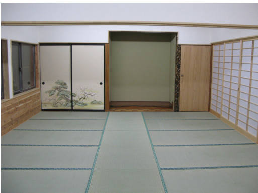
和室(天井・腰壁:スギ)
