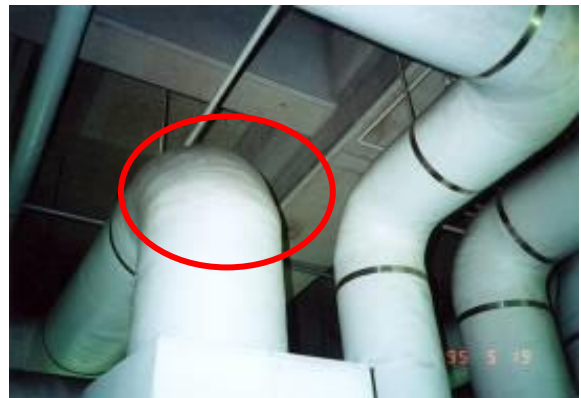
保温材（配管等）
