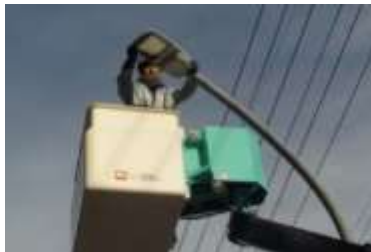
【道路照明灯のLED化工事】
