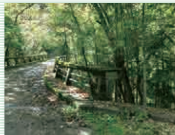
駅を出るとすぐに、米川橋を渡ります。渡ると、泰阜村に入ります。
