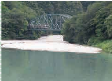
天竜橋から見た飯田線の鉄橋
