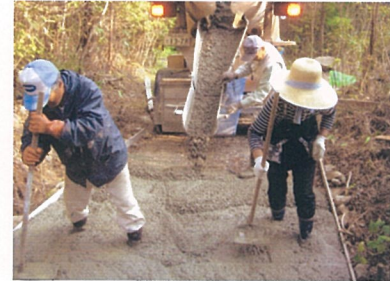
【コンクリート舗装作業】
