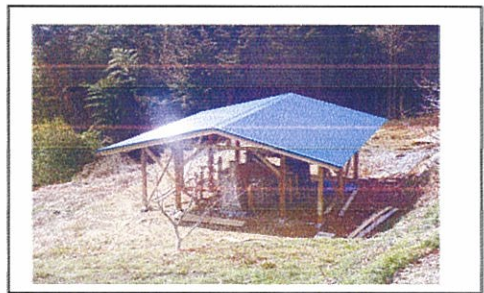
【21.3 炭焼小屋完成】
