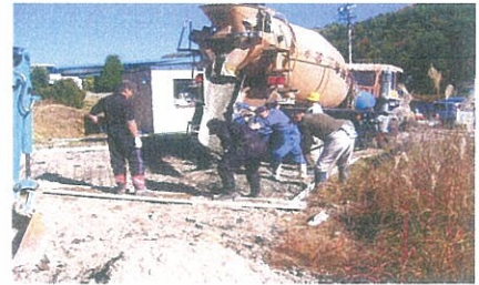
【コンクリート舗装作業】
