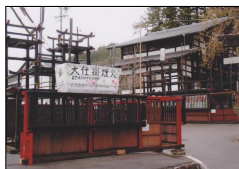
【囲い櫓修繕完了写真】
