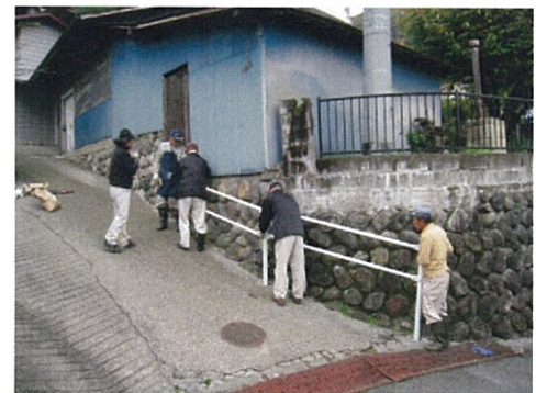
【長野・長野町区の手すり設置】
