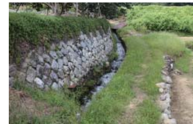
石積みと水路
