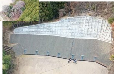
地すべりにより崩落した斜面へ対策工事を実施（地すべり対策事業 平久地区）
