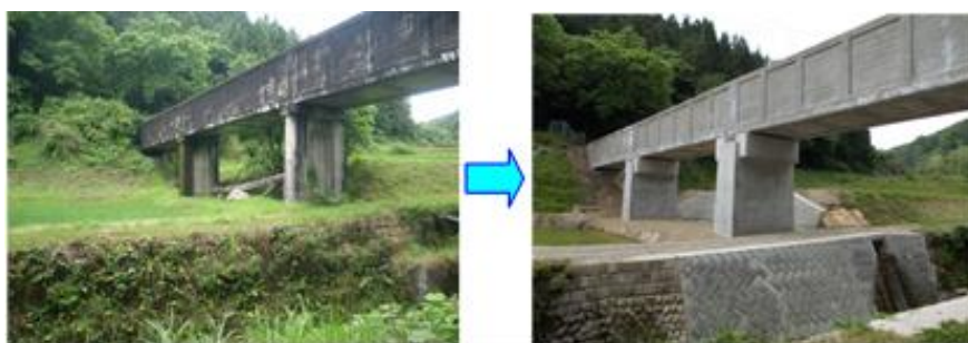
耐震補強が完了した胡麻目沢水路橋（竜西一貫水路）
