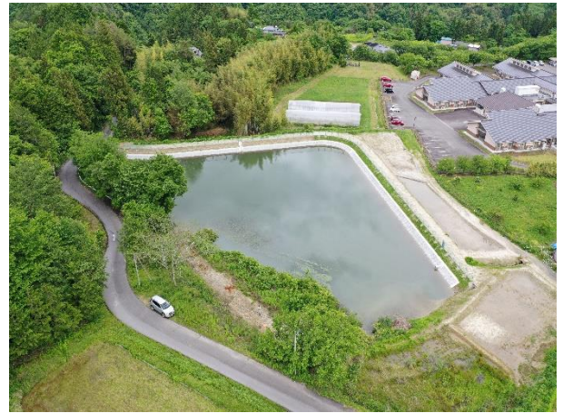
【ため池堤体の耐震改修（阿南町）】
