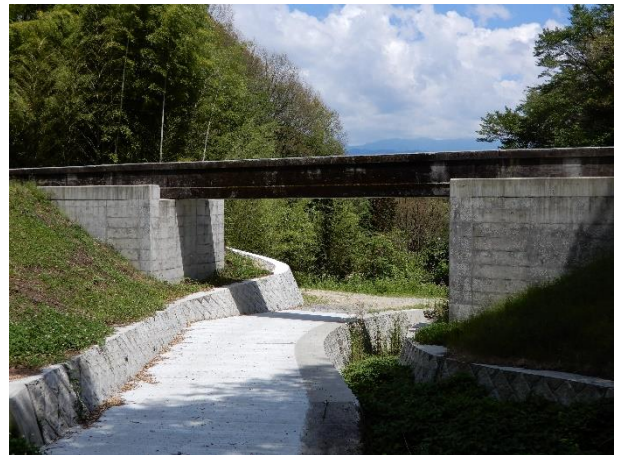
【水路橋の耐震補強（飯田市）】
