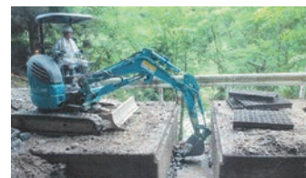
崩土・流出土砂片付け作業委託
