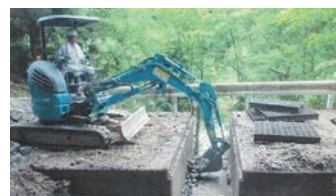
崩土・流出土砂片付け作業委託
