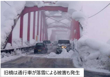
旧橋は通行車が落雪による被害も発生
