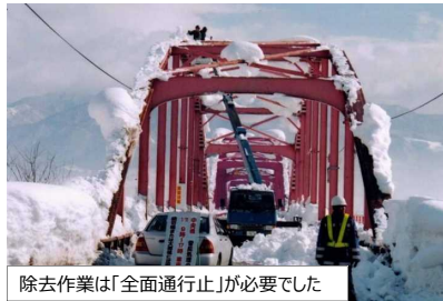
除去作業は「全面通行止」が必要でした
