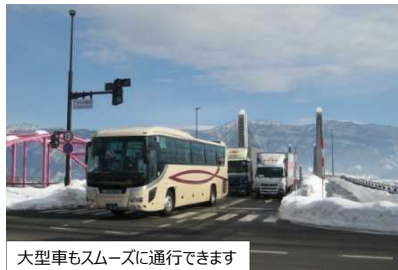
大型車もスムーズに通行できます
