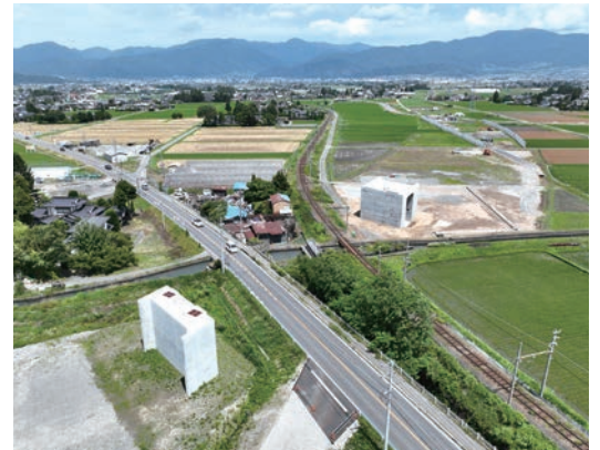
新村高架橋(工事中)
