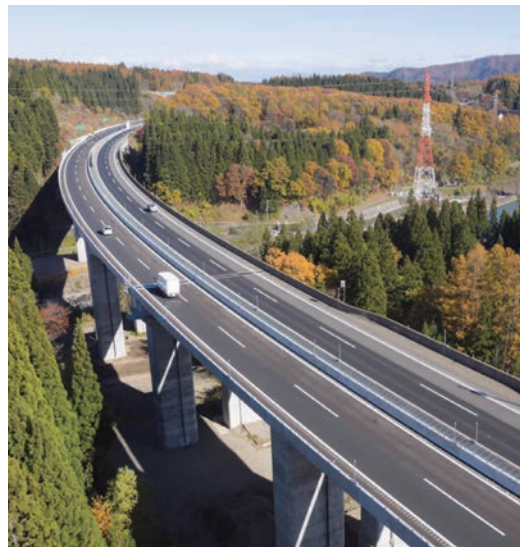
新潟県境の「れいめい橋」
