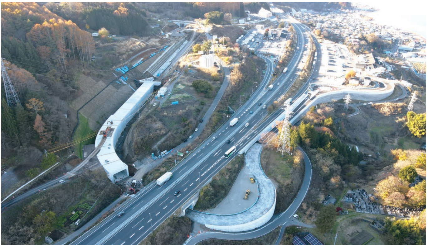
諏訪湖SIC工事中(諏訪市・岡谷市 中央自動車道)
