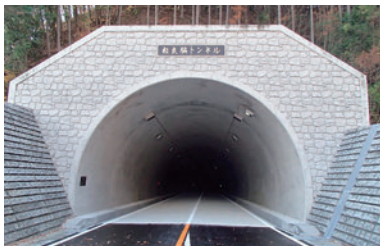
（国）151号 下條村 粒良脇トンネル
