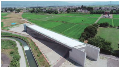
扇子田公園付近橋梁工事写真
