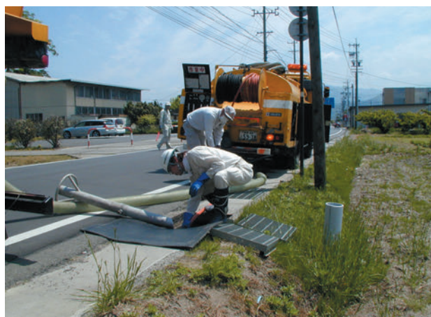
〔側溝清掃状況〕
