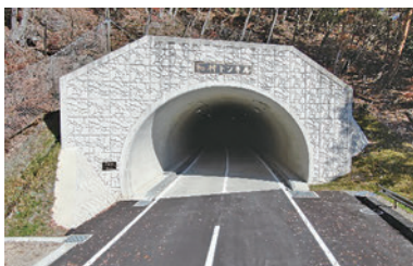
（一）上松南木曾線 大桑村 和村トンネル
