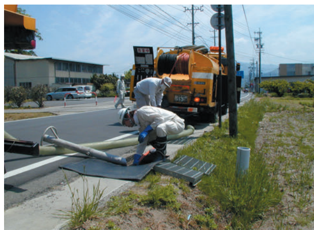
〔側溝清掃状況〕
