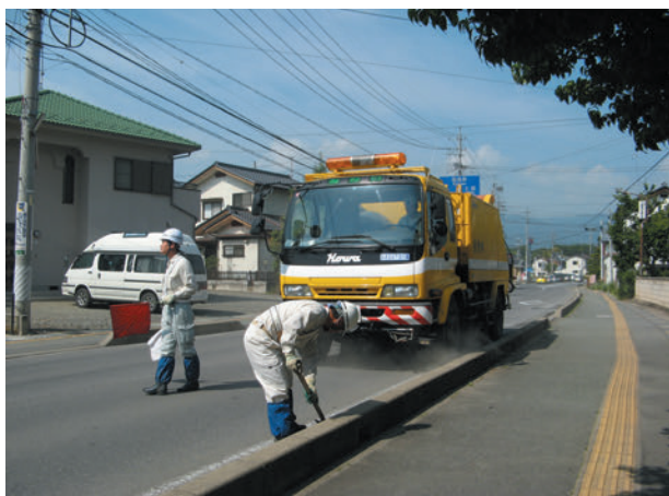
〔路面清掃状況〕
