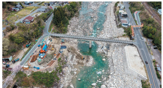
町道 川向棚野線 南木首町 高瀬橋（施工中）
