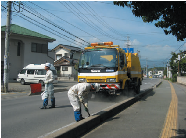
〔路面清掃状況〕
