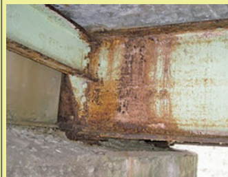
橋桁の腐食
