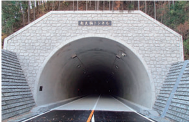
(国) 151号 下條村 粒良脇トンネル
