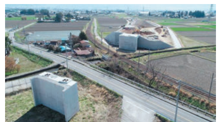
新村高架橋 工事中（松本市）
