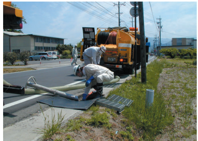
〔側溝清掃状況〕
