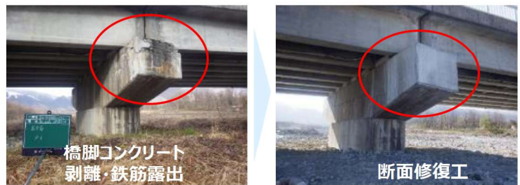
(国)148号 北安曇郡白馬村 松川橋
