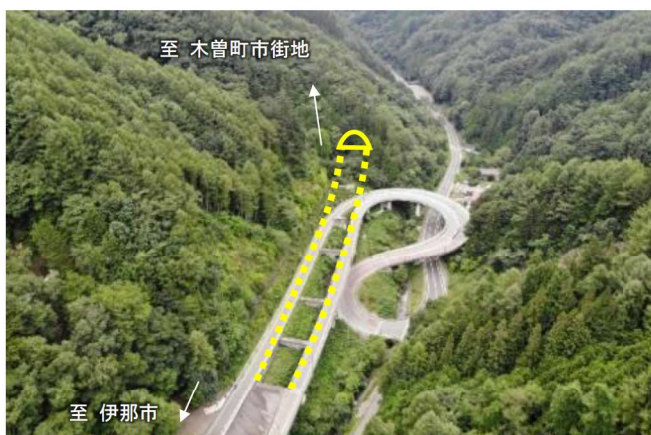
伊那木曾連絡道路(姥神峠道路(延伸))
