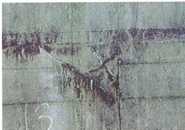
写真 2.1 ブロック化したひび割れの例<sup>1)</sup>
