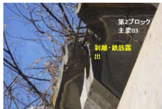
(1-1-1) おげんびし洞門 (うき、剥離・鉄筋露出) (1-1-2) 日向窪洞門 (剥離、鉄筋露出) 写真 1-1 主梁、横梁の損傷 (C2) の例
