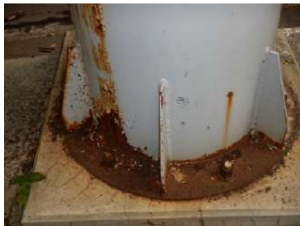
(1-1) 七倉 13 号スノーシェッド (柱)
