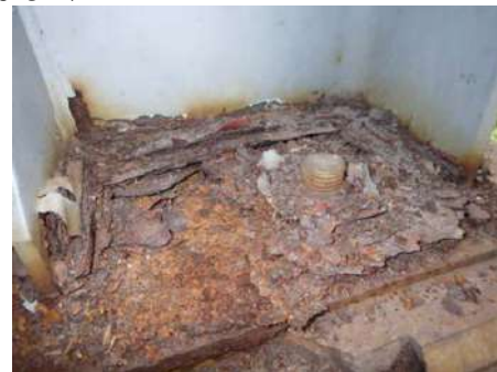
(1-4) 七倉 11 号スノーシェッド (支承部)
