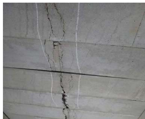
(1-2-1) 新山吹洞門 (ひびわれ) (1-2-2) 裾花洞門 (ひびわれ、うき) 写真 1-2 頂版の損傷 (C2) の例
