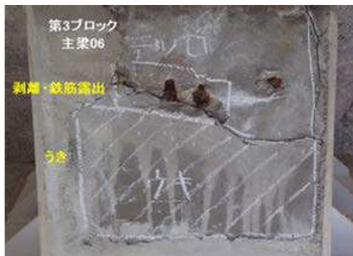
(1-1-1) おげんびし洞門 (うき、剥離・鉄筋露出) (1-1-2) 日向窪洞門 (剥離、鉄筋露出) 写真 1-1 主梁、横梁の損傷 (C2) の例
