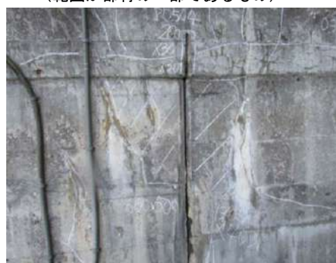
(3-4) 釜掛シェッド（谷側基礎）
