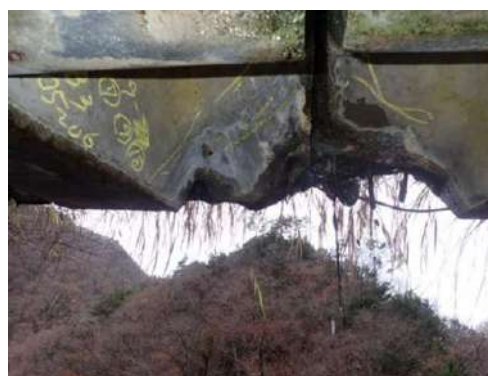
(4-2) 小谷3号ロックシェッド (主梁)
