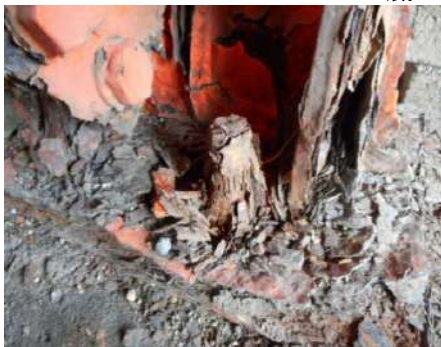
(1-3) 雪坪スノーシェッド (支承部)
