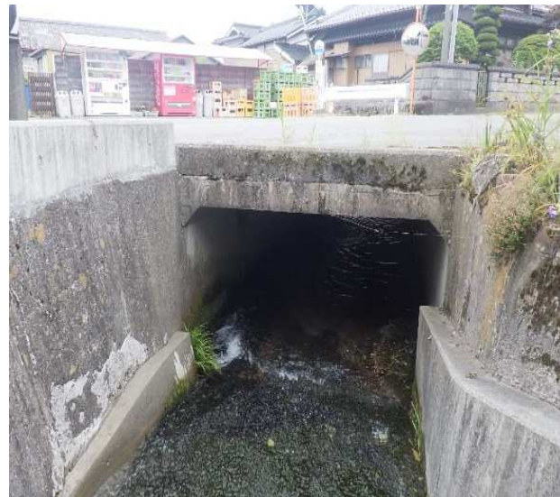
事例① RC床版橋 L=3.1m
