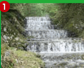
階段工上部 階段状水路。リズミカルに水が流れ落ちていきます。【大正7年完成】
