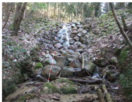
写真 12 西小洞第 1 堰堤
