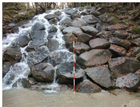
写真9 東の巣川第2堰堤
