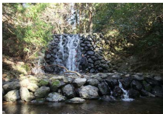
写真 7 釜ヶ谷の石積堰堤
