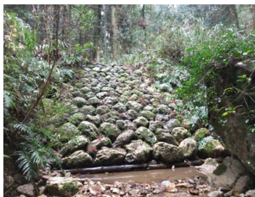
写真 5 岩舟川支川 1 の石積堰堤
