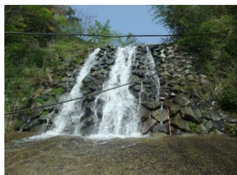
写真 21 小川谷の堰堤
