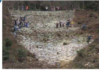
『近世以前の土木・産業遺産』の評価によると、【江戸期の砂留の中で最も高い堰堤、堰堤の天端が緩やかなアーチ状、堰堤のほぼ全幅が越流部になっていて、自然の勾配に沿って石が敷かれている】と記載があり、高く評価されています。
