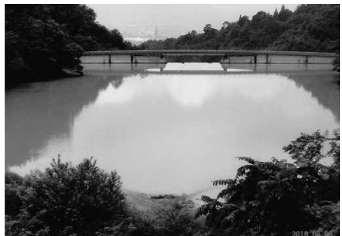
写真5.1.6 牛伏寺ダム貯水池が濁った大雨（濁ることの少ない牛伏川では希な現象だ）
