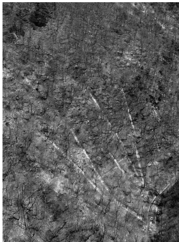
写真5.2.1 水路張石が効果を果たしている泥沢斜面の現況
