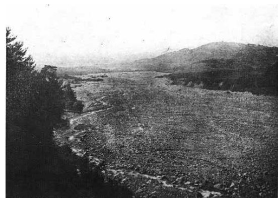
写真3 下流の土砂流出、堆積状況(撮影明治35年)
