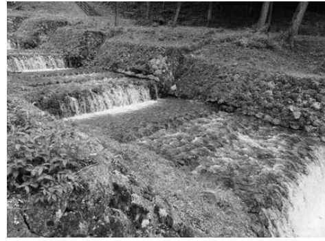
写真12 牛伏川階段工の床固工間の小落差
