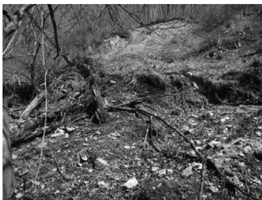
写真4.2.3 断層破砕帯を伴う崩壊地
