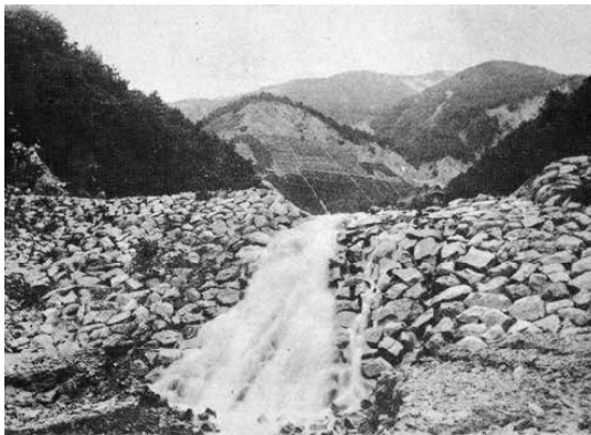
写真2 内務省4号堰堤(撮影明治44年)
