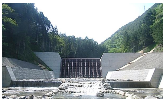
写真 2 再度災害防止のために、整備した砂防堰堤
