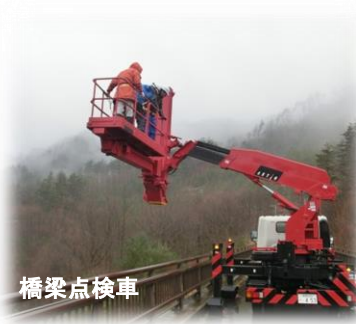
近接目視と打音検査
