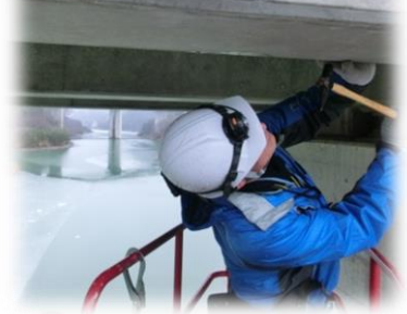
近接目視と打音検査
