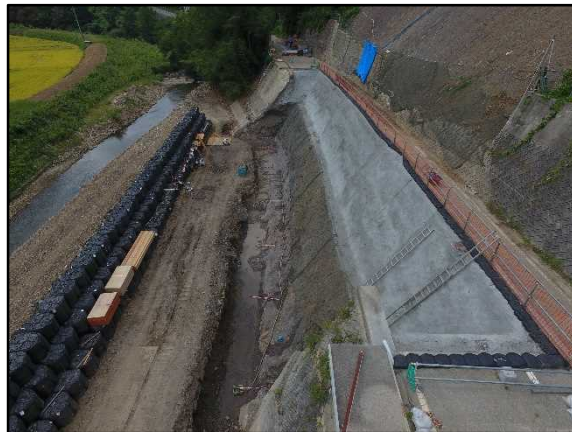
護岸整備前の掘削状況(令和元年9月中旬)
