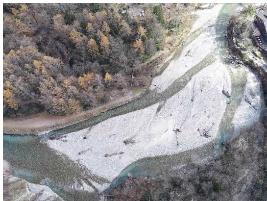
河童橋の上流にたまった土砂
