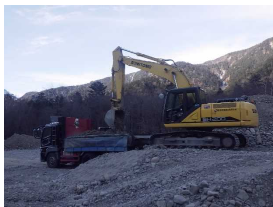
掘削した土砂をダンプトラックで搬出
