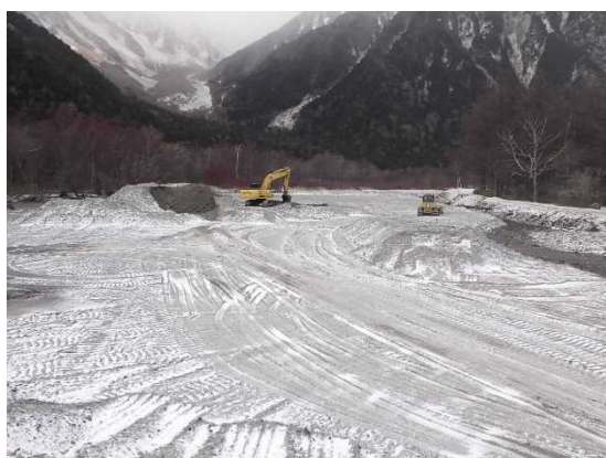
たまった土砂を掘削
