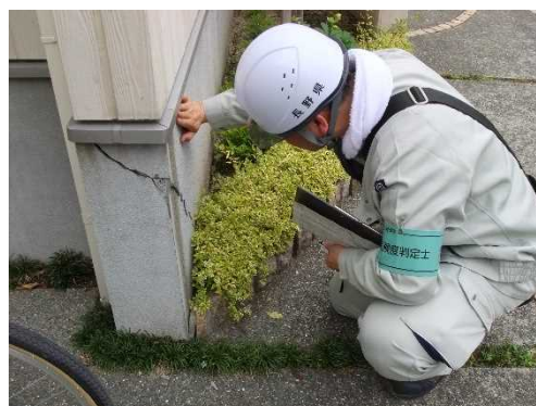
基礎のひび割れをチェックしている様子 (熊本地震での判定活動)
