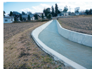
【更新した新村堰水路（松本市）】
