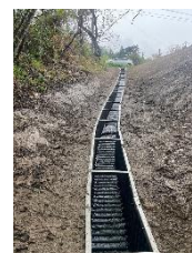
【地すべり対策 松本地区（板場）（松本市）】
