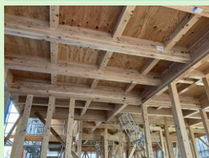
【松本市(M-one株式会社)】 ゲストハウスの木造化 ・調度品設置
