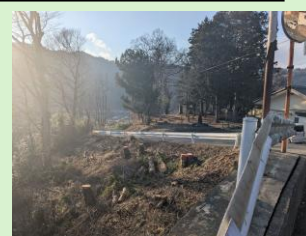
【生坂村】 村道沿いの危険木伐採
