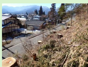
【朝日村】 県道沿線の危険木伐採
