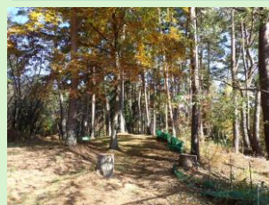
【松本市(美鈴湖もりの国)】 キャンプ場内の危険木伐採
