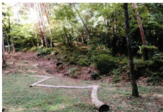
▲整備前 危険木等伐倒 (飯田市)
