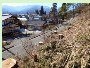
【朝日村】 県道沿線の危険木伐採
