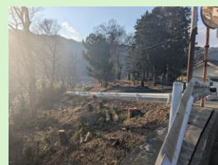
【生坂村】 村道沿いの危険木伐採
