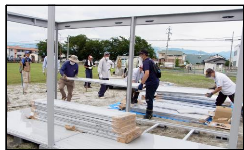
【地区住民による防災倉庫の組立、設置作業:7/16】
