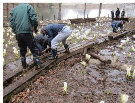
【遊歩道整備・まくら木交換】
