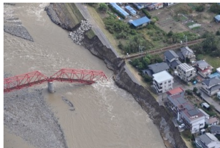
令和元年台風第19号の大雨による増水のため崩落した別所線橋梁
