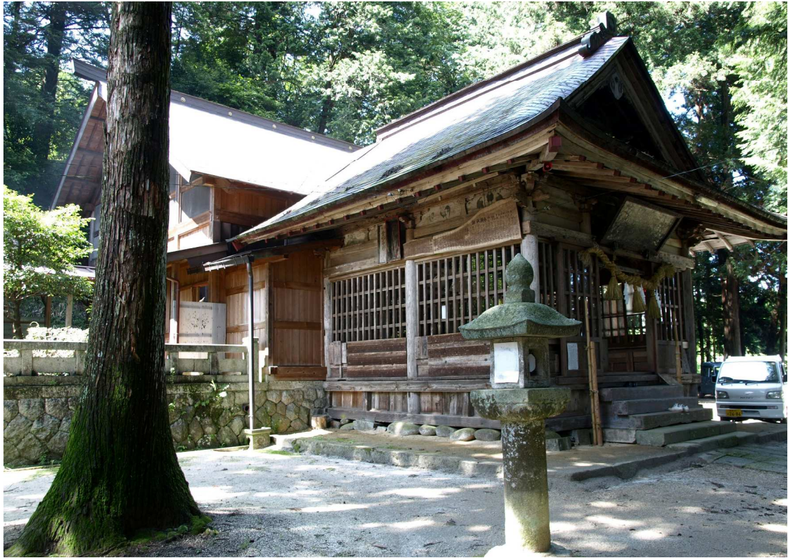
本殿覆屋 (左奥) 及び拝殿 (右)
