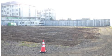
解体工事完了後
