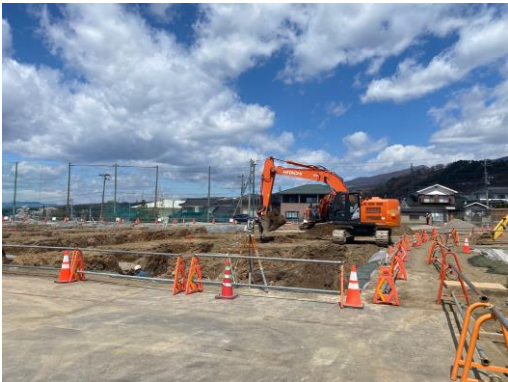
土工事(掘削作業)施工状況
