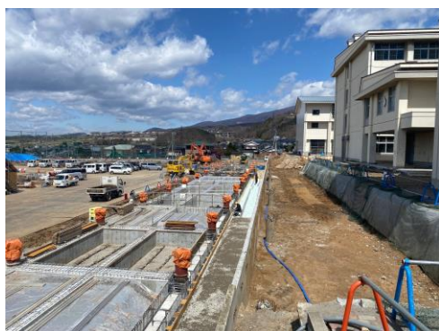
新棟基礎工事施工状況
