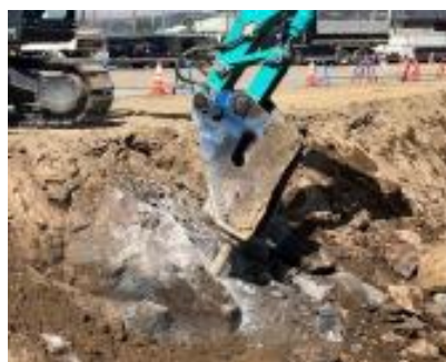
削岩機による転石の破碎作業状況
