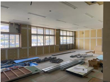
内装改修作業中
