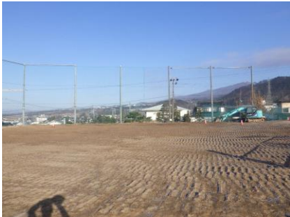
解体工事完了後
