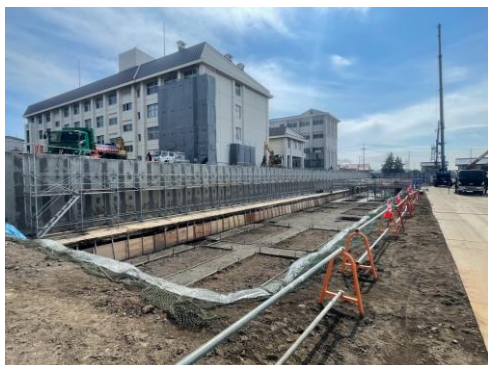
既存擁壁状況
