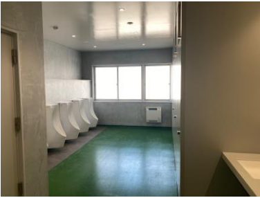
北棟トイレ改修完了状況
