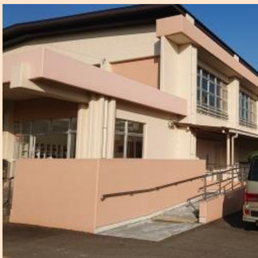
外からの車いすスロープの設置
