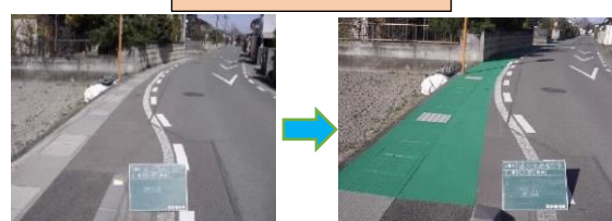
路面標示新設
