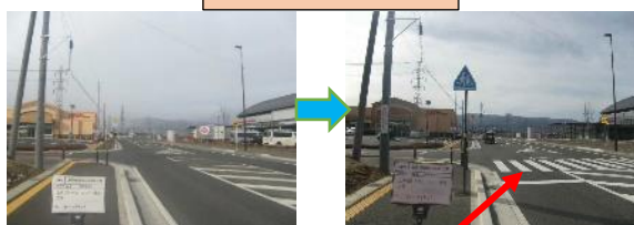
横断歩道新設
