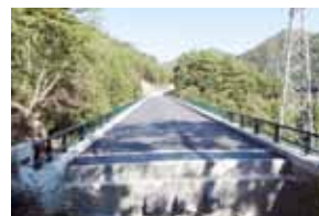
木曾右岸道路 (南木曾町川向わらび沢大橋)
