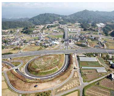
三遠南信自動車道 飯橋道路(飯田山本IC)
