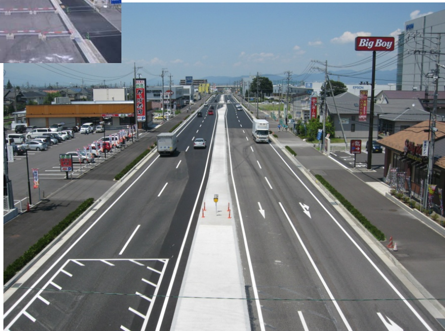
施工後の状況 (広丘消防署交差点付近 松本方向)
