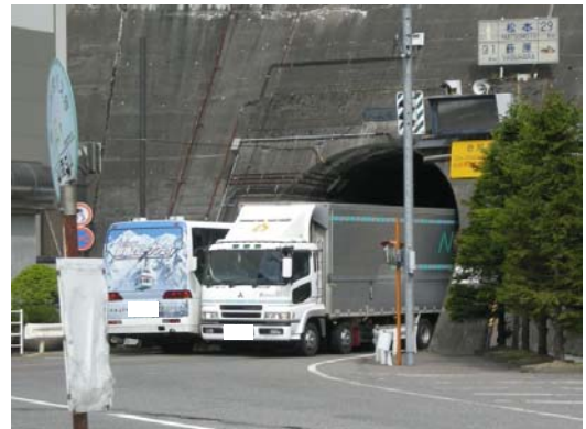
大型車のすれ違いが困難な新入山トンネル(奈川渡ダム側坑口)
