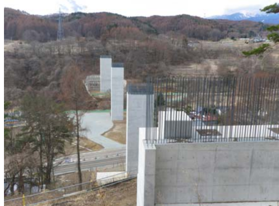
工事が進む八千穂 IC (仮称) 付近
