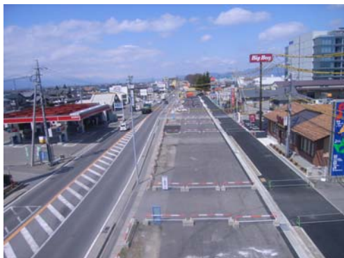
施工中の状況
