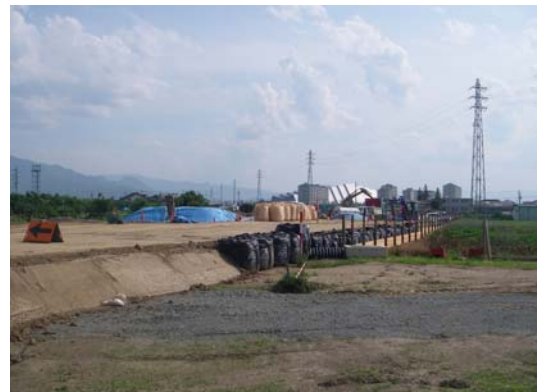
工事の状況(北長池改良工事:高崎方向)
