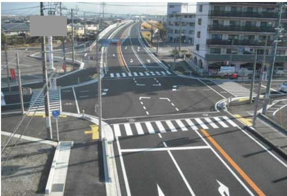
国道19号 交通安全事業(交差点改良) 塩尻市
