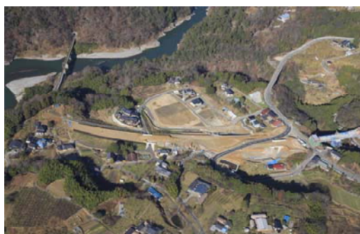
千代IC(仮称)の工事状況
