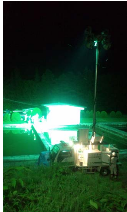
照明車稼働状況
