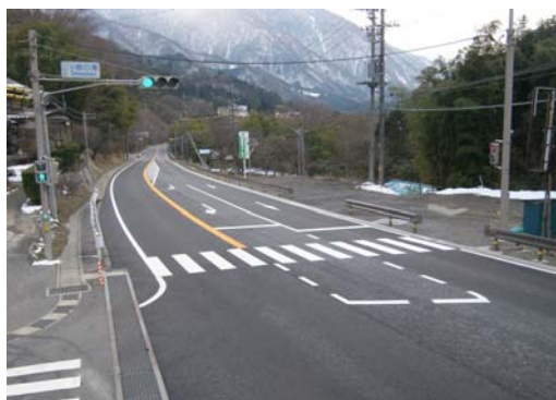
交差点改良 （国道19号上松町小野の滝交差点）
