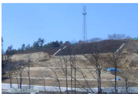
田切地区の工事状況
