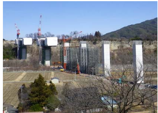
国道153号 伊南バイパス
