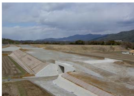
飯島地区の工事状況
