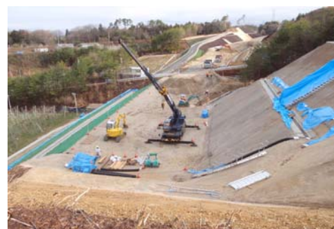
龍江地区の工事状況
