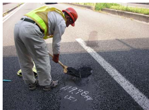
道路維持作業（舗装補修）
