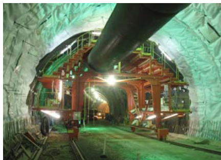
棧トンネルの工事状況
