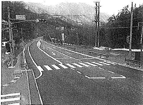
交差点改良 (国道19号上松町小野の滝交差点)
