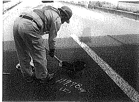
道路維持作業（舗装補修）
