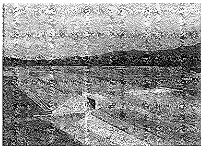
飯島地区の工事状況
