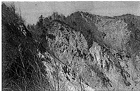
青崩峠崩壊地
