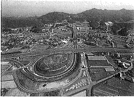
三遠南信自動車道 飯橋道路
