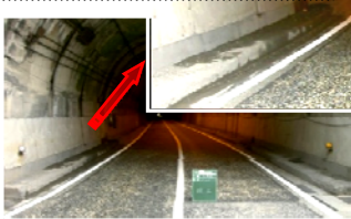
トンネルの漏水状況
